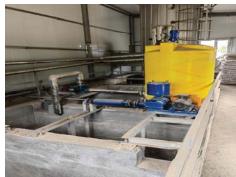
项目除尘脱硫现状
