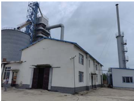
项目现有热风炉间现状
