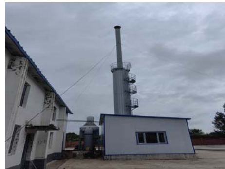
项目除尘脱硫间现状
