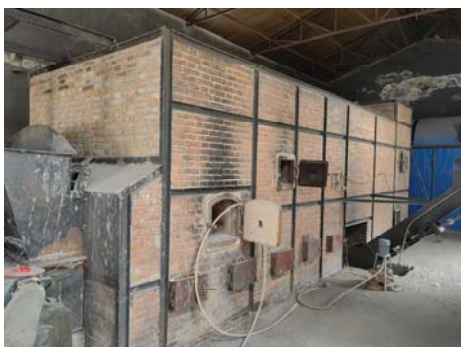
项目现有热风炉现状
