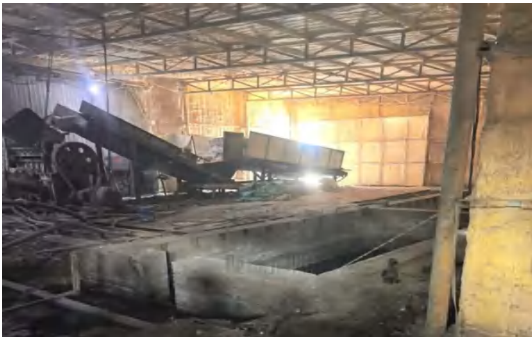
清洗废水沉淀池
